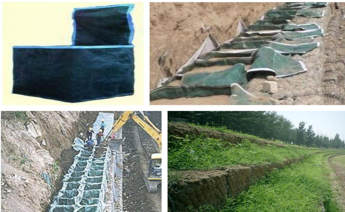
图 12-1 机织有纺土石笼袋工程运用实例图
