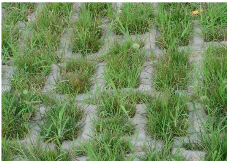
图 7-1 开孔式混凝土砌块图
