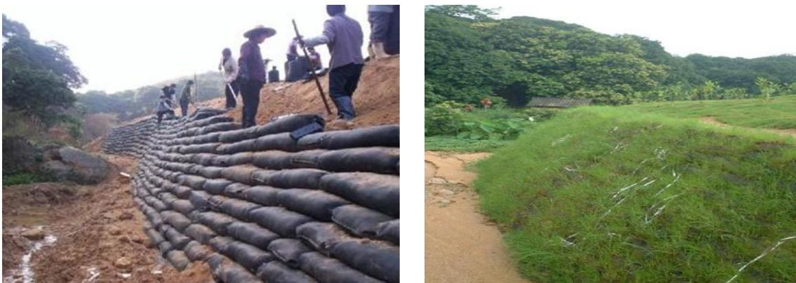
图 9-2 生态袋边坡防护图
