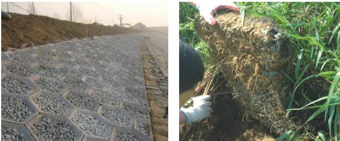
图 6-1 生态混凝土护坡图
