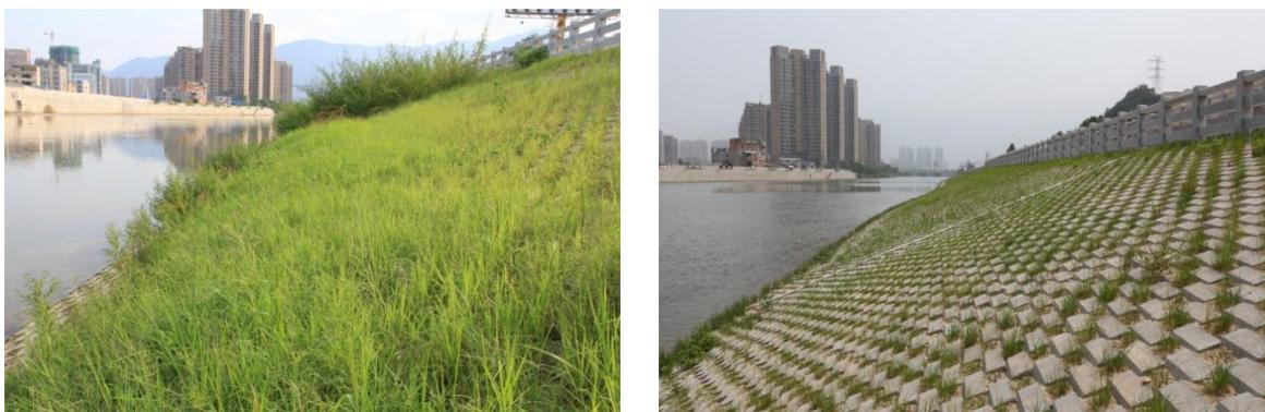
图 8-1 自锁式生态护坡砌块护岸图
