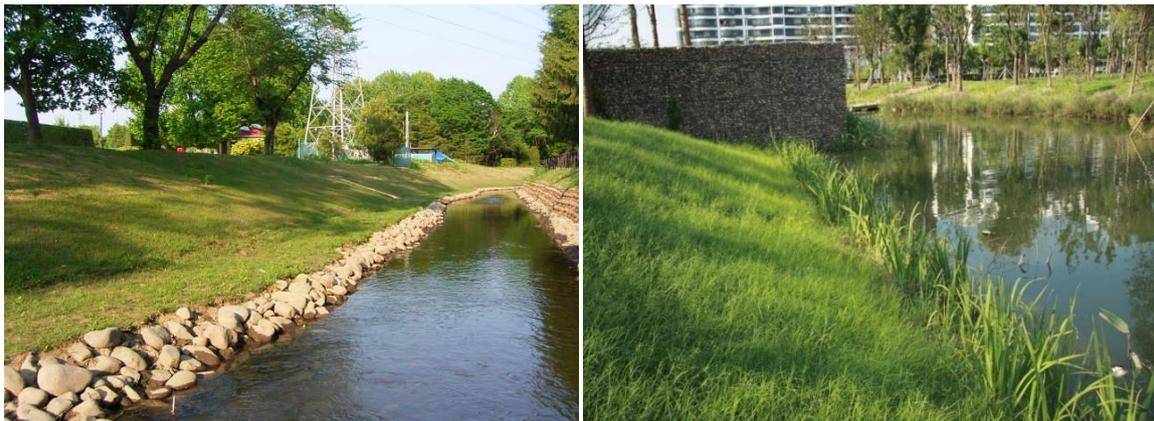
图 15-2 河道抗冲生物毯护坡图
